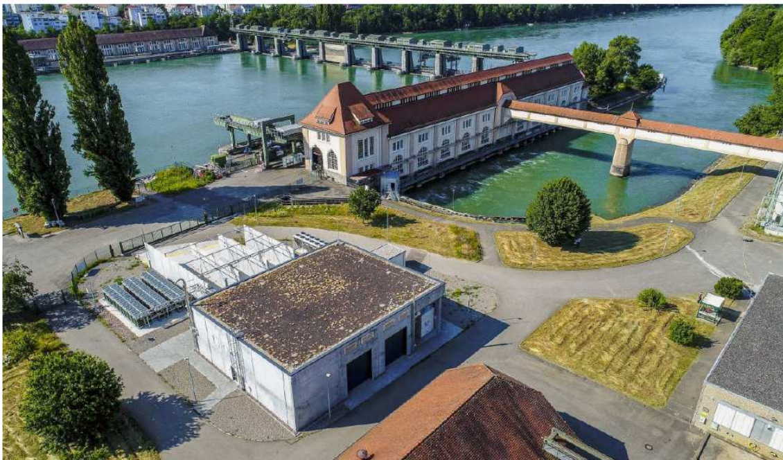
Die industrielle Power-to-Gas-Anlage am Wasserkraftwerk in Grenzach-Wyhlen gegenüber Kaiseraugst am Rhein produziert zuverlässig Wasserstoff.
