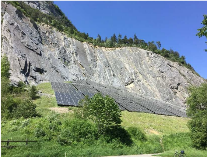
Grösste Freiflächenanlage Graubündens im ehemaligen Steinbruch Calinis in Felsberg (seit Sommer 2020 am Netz)
